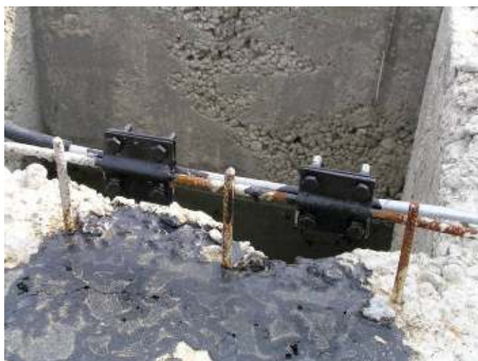
Slika 5 – Konačno izveden priključak za spajanje armature temelja ("armaturnog koša") sa zemljovodom stabla zajedno sa termoskupljajućom cevčicom od polietilena crne boje sa lepkom
