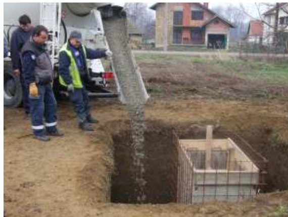
Slika 1 – Nalivanje betonom tela temelja sa postavljenom armaturom ("armaturnim košem") koja će se iskoristiti za temeljni uzemljivač
