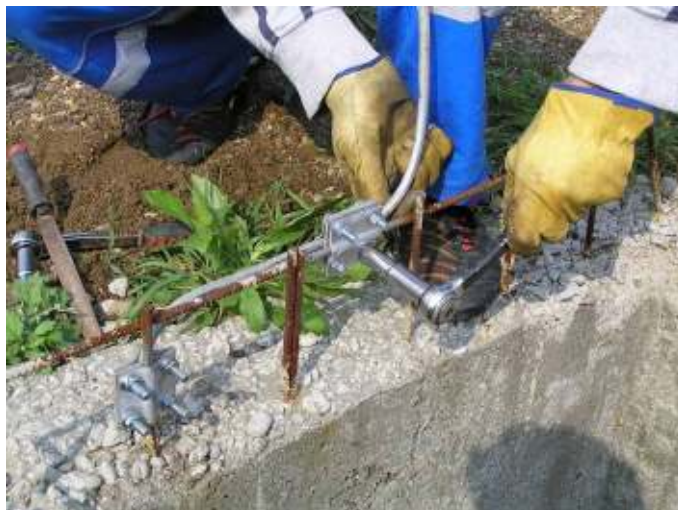
Slika 4 – Praktično vezivanja priključka za spajanje armature temelja ("armaturnog koša") sa zemljovodom stabla na gornji venac mrežaste armature
